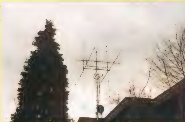
Meerdere twee-elementen quads voor diverse HF-banden, met er binnenin een 10-elementen quad. Bovendien staat er ook nog een halve golfstraler voor 2 meter tussen de HF-elementen. Omdat de verticale antenne niet parallel aan de elementen van de quad staat opgesteld, zal er wel enige invloed zijn, maar deze is niet al te groot.
